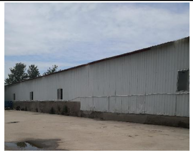
东侧舞阳县鑫丰新型建材有限公司现有厂房
